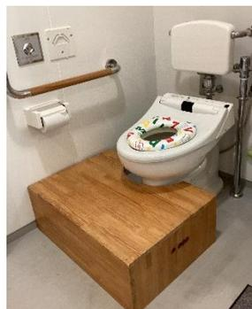
便座に座ったときに足が浮いていると、姿勢が安定しません。足底が床面に接地するように、発泡スチロールブロック等の足台を置きます。低学年の小柄な児童が使用するトイレでは、より安定するような足台を設置しています。
